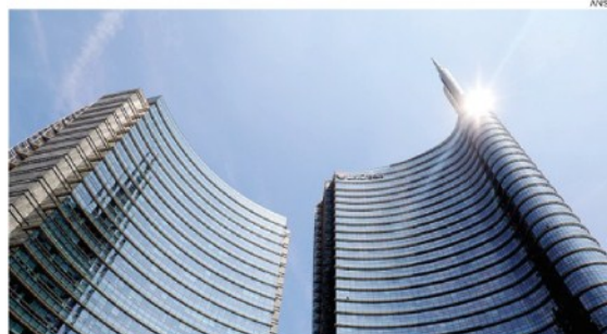
Unicredit tower. Il quartier generale del gruppo a Milano
